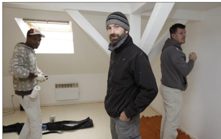
Gilles Pierson, encadrant technique, avec une équipe sur un chantier de réfection d'un appartement géré par l'Alsa, rue de la 4 e DMM à Mulhouse. Photo L'Alsace/Hervé Kielwasser
