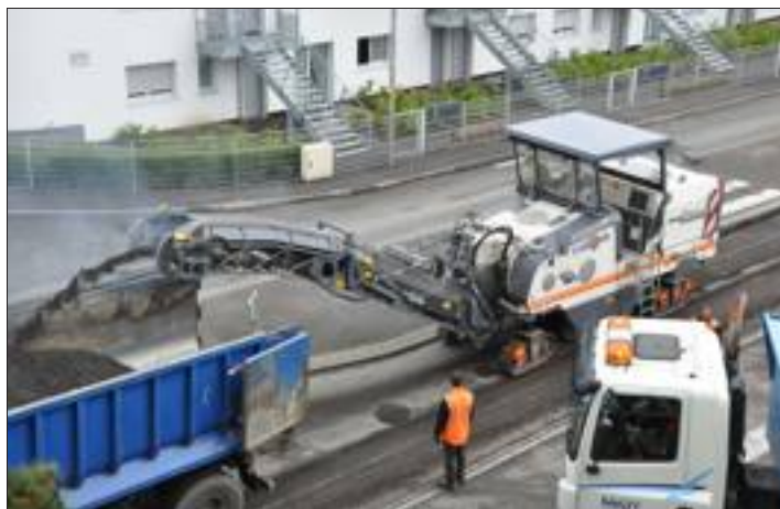
Le décroûtage de la chaussée est toujours impressionnant. Photo Justine Nalouei
